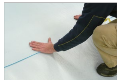
(3) Een goede afdichting van de overlapping verzekeren
